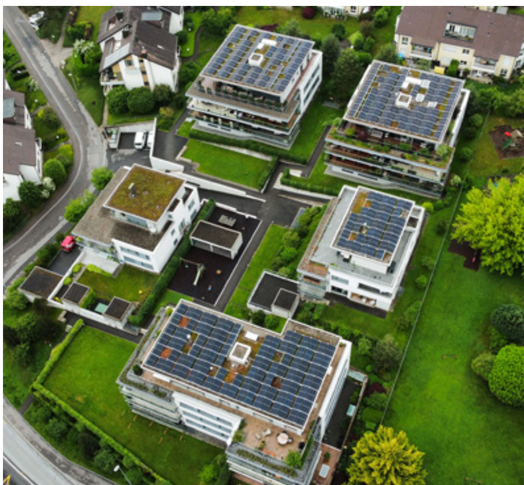
Den eigenen Strom nutzen und zusätzlich Geld damit verdienen: Die Photovoltaikanlage auf ihren vier Hausdächern lohnt sich für die StWEG im «Hof Himmelrich» doppelt.
